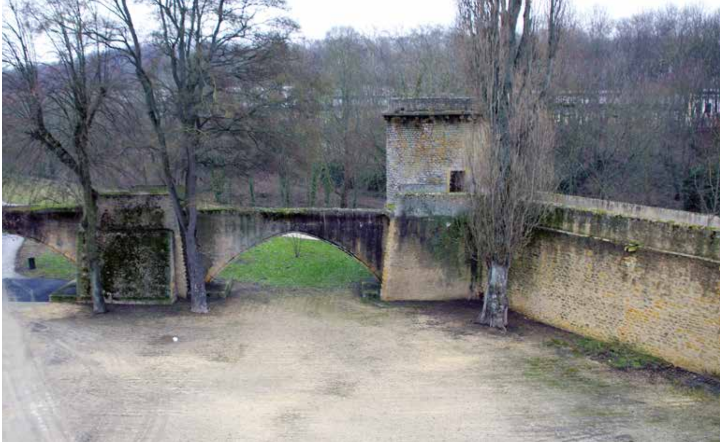
1 – Tronçon relevé en 2001 comprenant, de gauche à droite, le pont des Grilles de la Basse-Seille, la Tour des Barbiers et des Chandeliers de cire et le mur de courtine. Cliché Julien Trapp.
