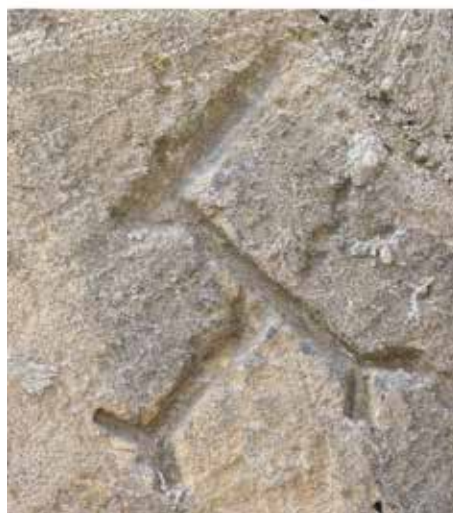
8 – Marque lapidaire gravée sur l'arche ouest du pont des Grilles de la Basse-Seille. Cliché Yvain Daune.
