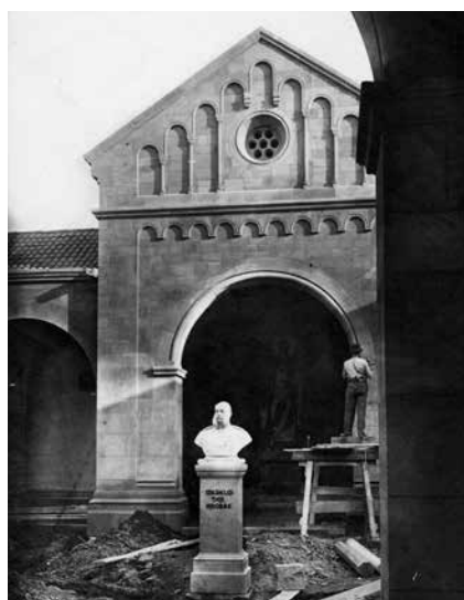
Fig. 2 : La Halle du Souvenir en travaux (Arch. départ. Mos. 14 T 12). On remarque le buste de Guillaume I er et un sculpteur au travail.
