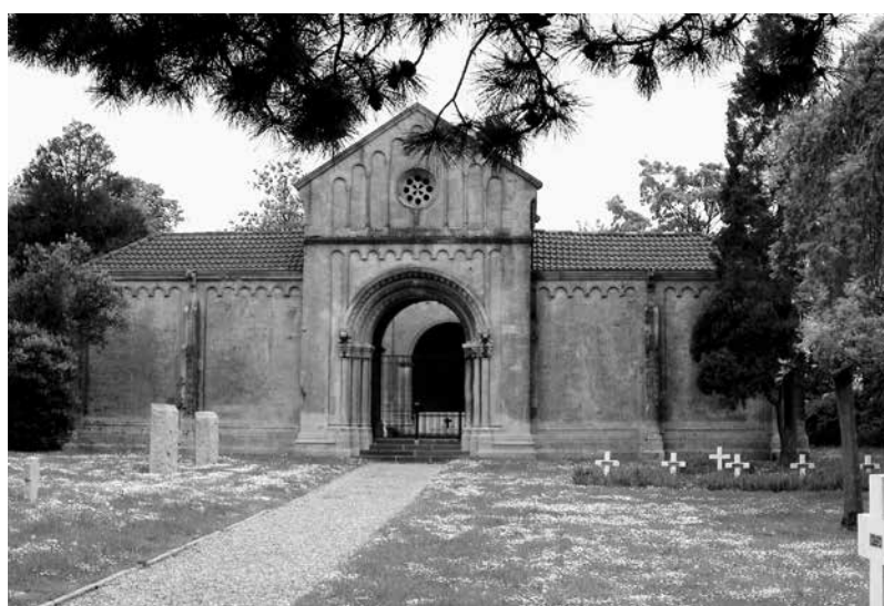
Fig. 4 : La Halle du Souvenir, état actuel. L'aménagement paysager d'origine a disparu ce qui nuit à la qualité du lieu.
