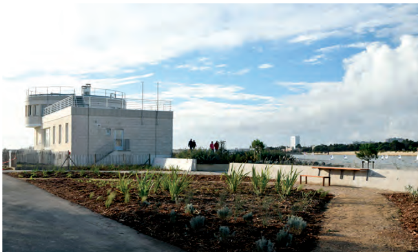
Figure 1. Pour se protéger des submersions marines, un mur en béton part du centre Météo-France. Il intègre du mobilier urbain.
