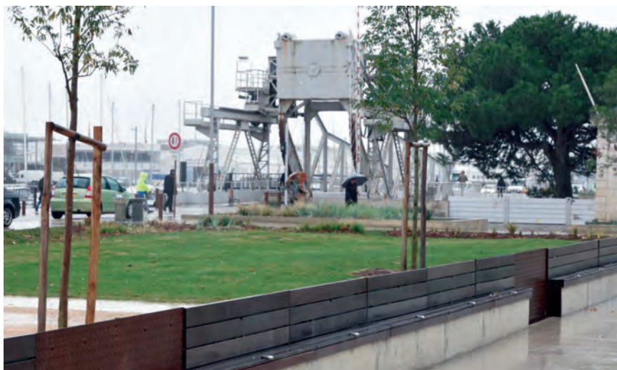
Figure 7. Dans ce petit square très fréquenté, l'assise des bancs se relève, ainsi que les plaques de tôle entre les bancs constituant une barrière étanche entre la mer et la ville.
