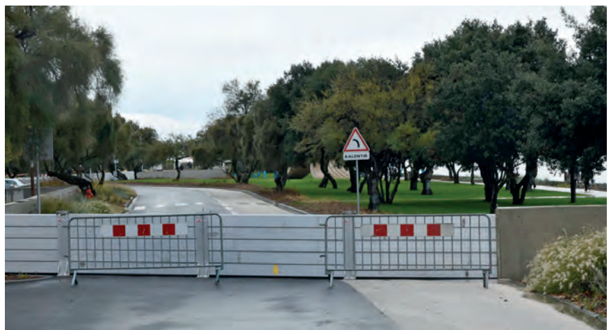
Figure 4. En cas d'alerte vagues-submersion, potelets et batardeaux sont mis en place pour assurer la continuité de la protection contre l'inondation.
