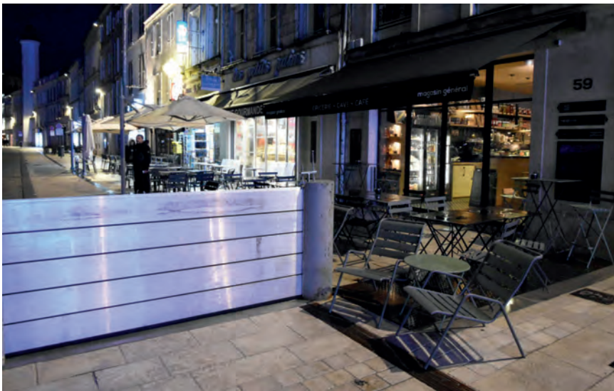
Figure 10. Lors de l'exercice de novembre 2018, la dernière partie de la protection qui rejoint la façade n'a pas été installée afin de ne pas entraver la circulation du public.
