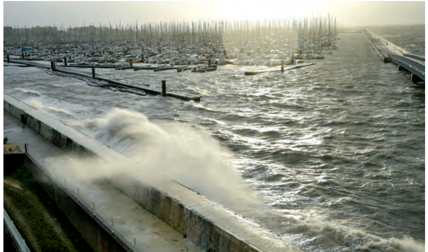
Figure 2. Par grande marée et coup de vent, le nouveau bassin du port de plaisance et sa jetée à droite ne sont pas suffisants pour empêcher totalement les vagues de monter à l'assaut de l'ancienne digue.
