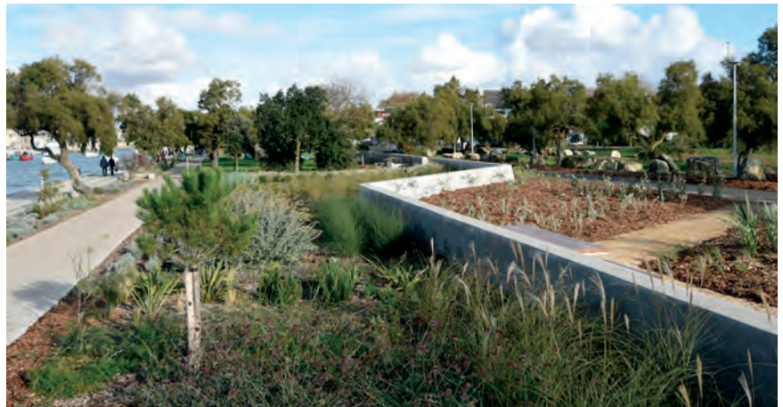
Figure 3. Vue du mur de protection qui disparaîtra bientôt sous la végétation.
