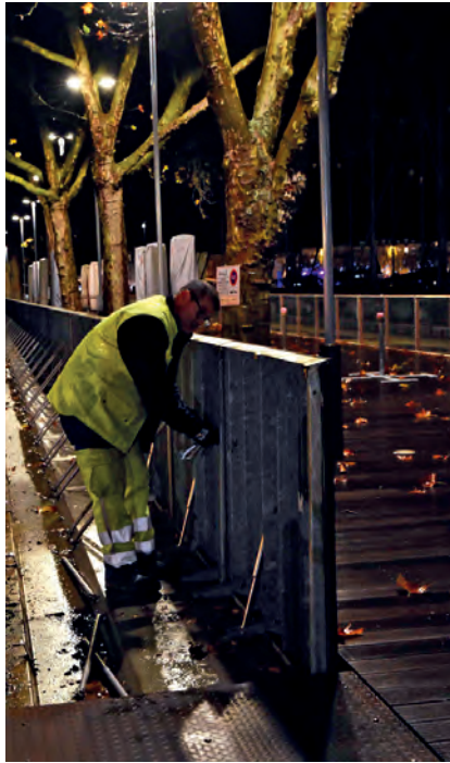
Figure 9. Quai du Gabut, des clapets mobiles sont relevés manuellement en cas d'alerte. Habituellement, le lieu est envahi par les terrasses des restaurants.
