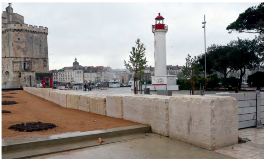
Figure 8. À proximité de la tour Saint-Nicolas, la protection prend la forme d'un mur de pierre rappelant l'existence des anciens remparts.
