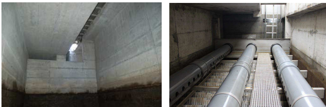
Figure 1 : Avant et après aménagement des bassins en décanteurs lamellaires
