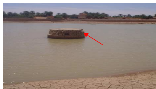
Photo 4 : Puit capteur du barrage Bouchène
