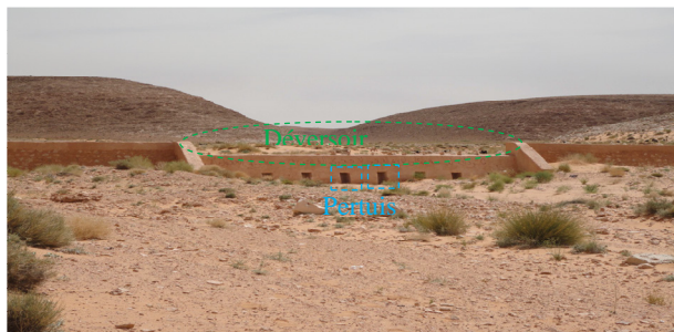
Photo 3 : Digue d'Inrez à sec
