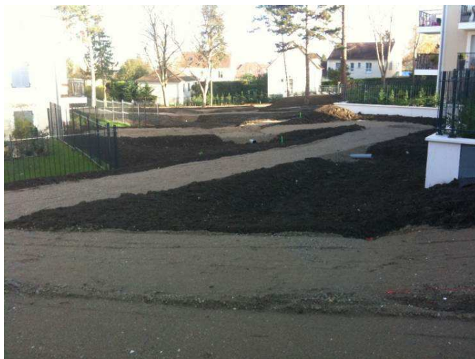
Photos des terrassements
