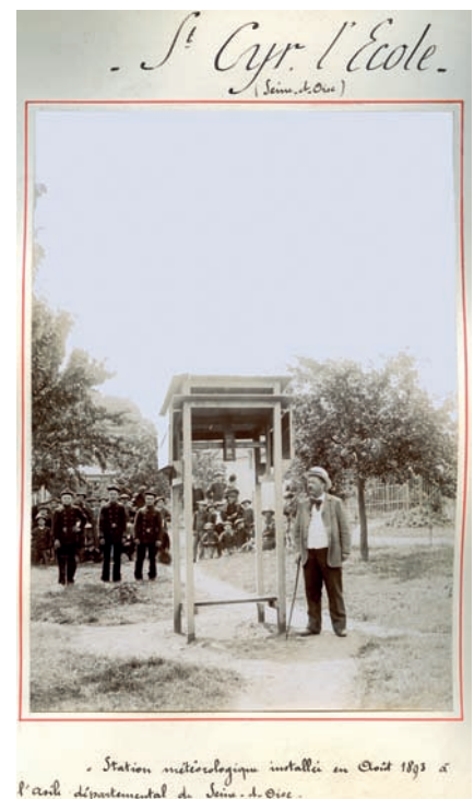
Figure 6. L'abri français ouvert, dit de Montsouris, de la station météorologique de Saint-Cyr l'École en 1899. Photo extraite d'un album de photographies des postes météorologiques de la région parisienne à la fin du XIX e siècle, conservé à la bibliothèque de Météo-France (© Météo-France).
