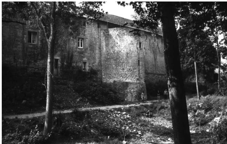
Fig. 7-8 : Vue de la courtine et des tours du XIII e siècle du flanc nord du château des évêques en 1984, photos de Gabriel Stiller.
