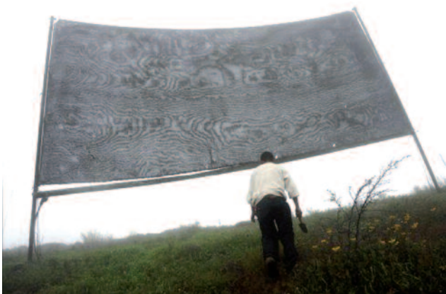
Figure 2 : Filet à brouillard (crédits photographiques : Fog Quest®). Le filet est tendu sur le trajet de la brume marine, chargée en microgouttelettes d'eau et permet l'interception de cette eau qui ruisselle le long des mailles.
