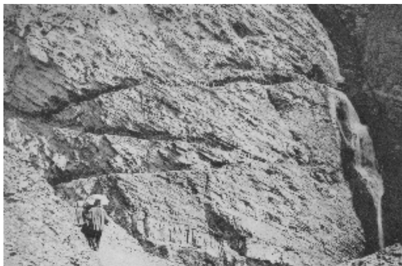
Photographie 4 Torrent de St-Julien - En route pour l'inauguration du tunnel de St-Julien Cliché Charles KUSS, 1896
