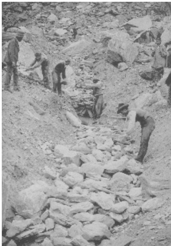
Photographie 3 Construction de drains en 1887. Une branche secondaire. Torrent de Sécheron
