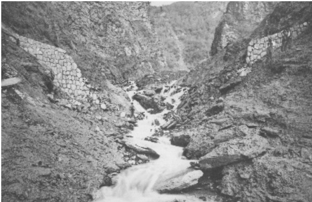
Photographie 6 Barrage n° 4 après la lave - Torrent de Nant Trouble
