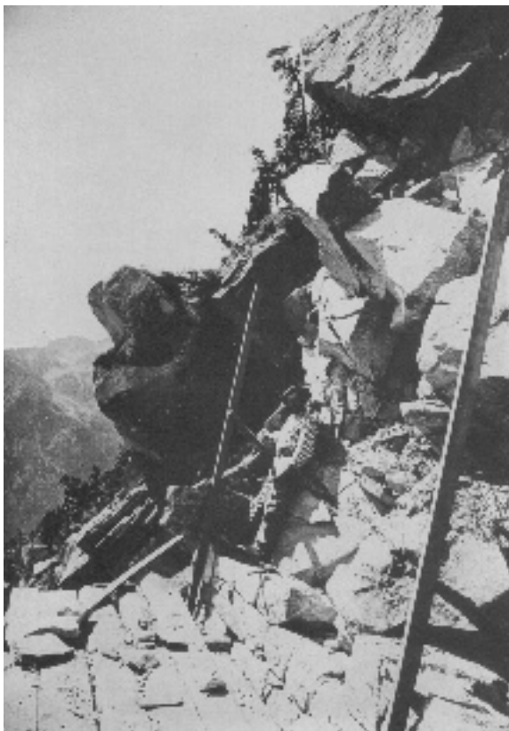
Photographie 2 Détail de la construction du groupe XVI. Combe de la Pégrière
