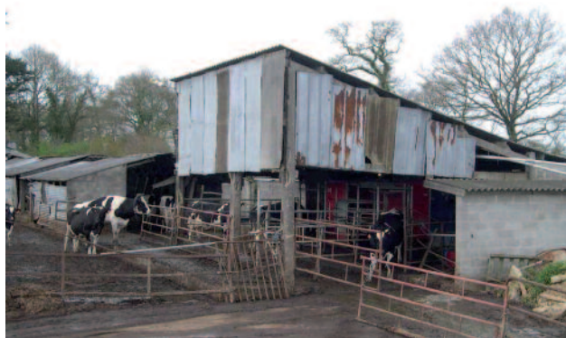
Figure 3 : Un choix risqué : un robot de traite installé dans un bâtiment vétuste.
