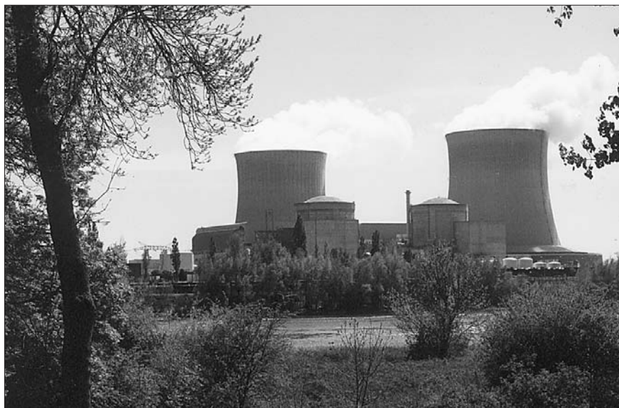
La centrale nucléaire de Saint-Laurent-Nouan (Loir-et-Cher).
