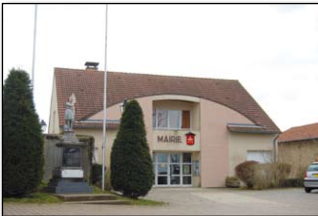
Mairie d'Altwiller (2009). Photographie Line Skorka.
