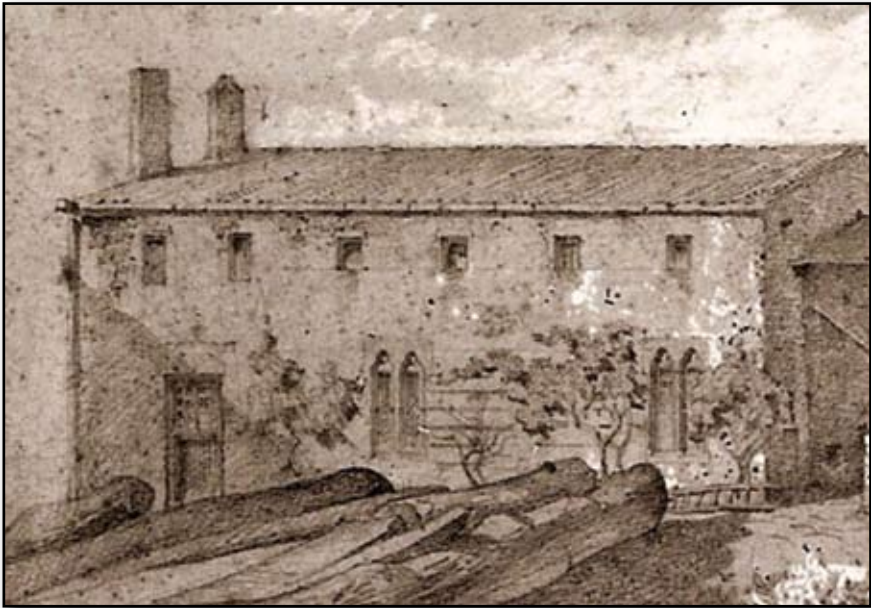
Ancienne abbaye Sainte-Marie, face extérieure côté est de la salle capitulaire improprement désignée comme réfectoire des Templiers (détail).
