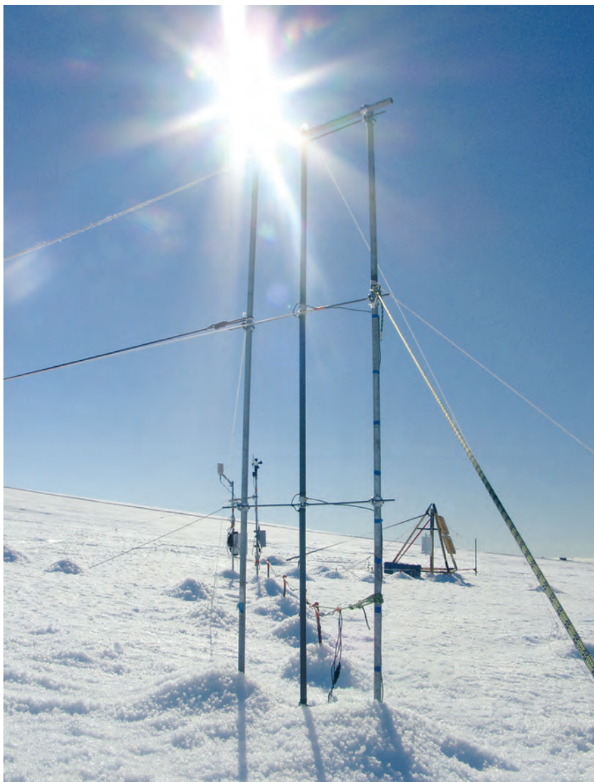
Figure 2 - La station de mesure de neige soufflée à D3. Au premier plan, les 3 tubes FlowCapt superposés bout à bout en position verticale. À l'arrière plan, une station météorologique et la « pyramide » énergie (éolienne et panneaux solaires) alimentant l'ensemble. (© Christophe Genthon, CNRS/LGGE)
