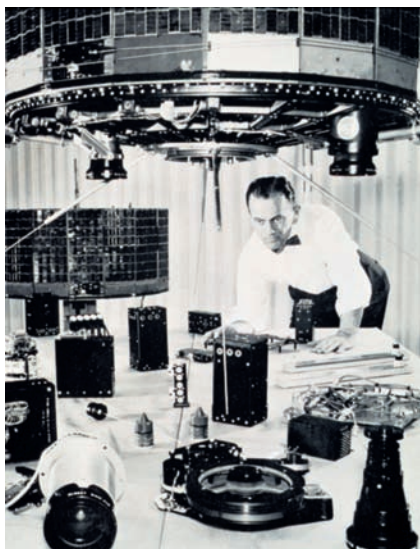
Figure 2 - Composants du satellite Tiros . Au premier plan on voit un enregistreur magnétique entre les deux caméras de télévision. (© NOAA)
