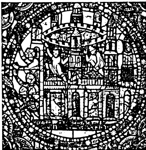
Etat en 1976 après restauration
