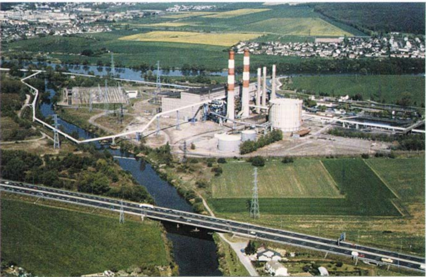
La centrale au confluent de la Moselle et de l'Orne.
