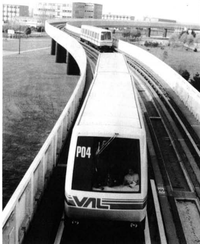
1. Poste de commande centralisé du VAL à Lille 2. La première ligne du métro de Lille équipée du système VAL est ouverte au public en 1983
