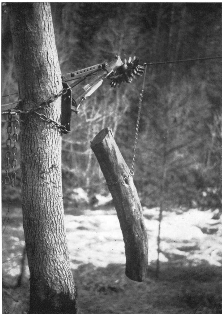
Vidange par câble-lasso. Passage d'une charge au niveau d'une « console ». (Photo Câble-Lasso, à Bâle).
