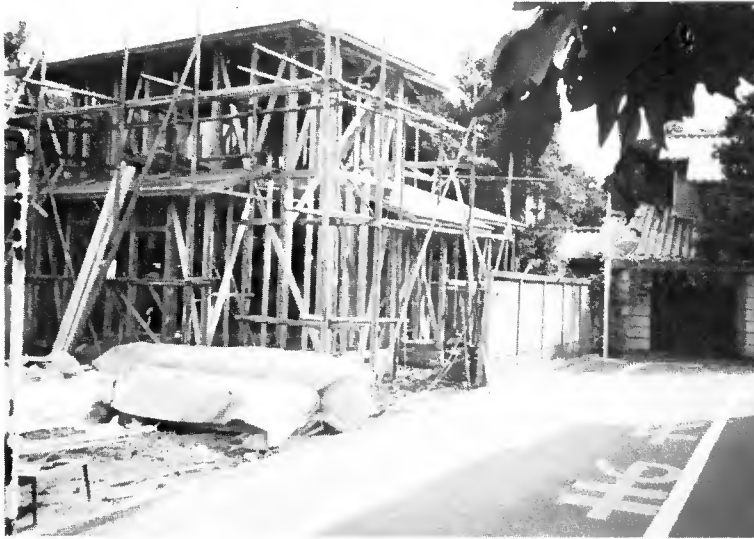
Construction d'une maison en bois dans un quartier de Tokyo (Bunkyo-ku).
