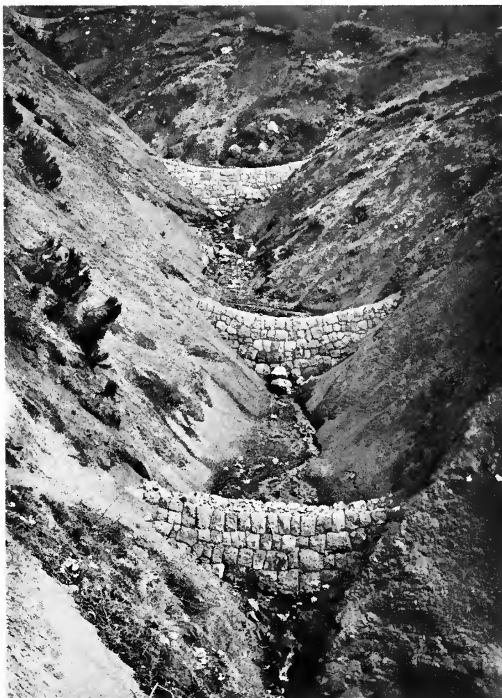
Une série de seuils en pierres sèches dans les moindres ravines... Série des Dourbes. Ravin de l'Areste. Photo X...
