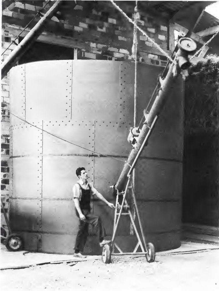
◀ Silo à grains en panneau de fibres dur.
