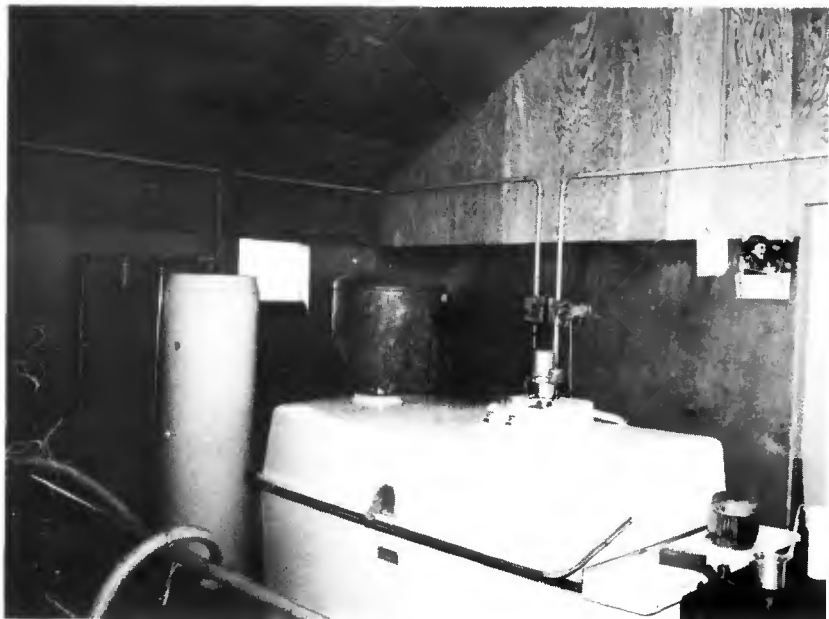
▶ Laiterie en contreplaqué. Pour l'hygiène du lait, les contreplaqués de la partie inférieure du mur sont revêtus d'un film phénolique.
