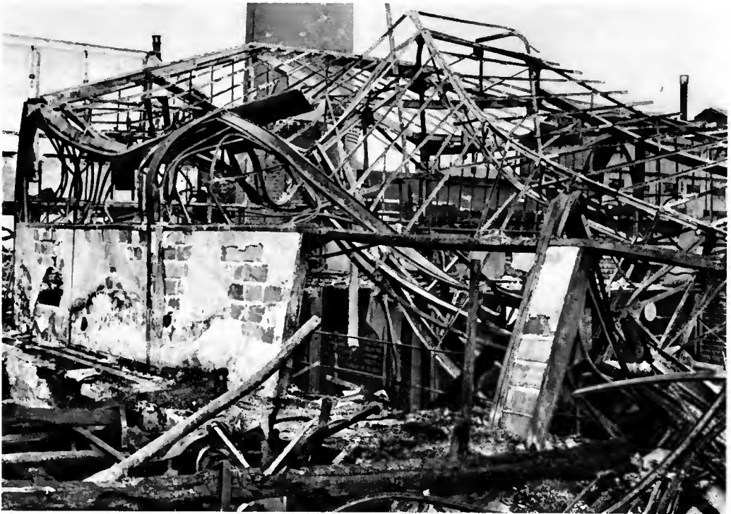
Comportement au feu d'une charpente en fer. Les grosses pièces ont été déformées sous l'action de la chaleur Photo CENTRE TECHNIQUE DU BOIS
