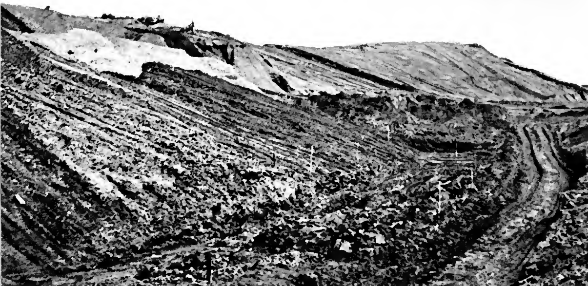
▲ Terril de Brinkforstheide en cours de construction
