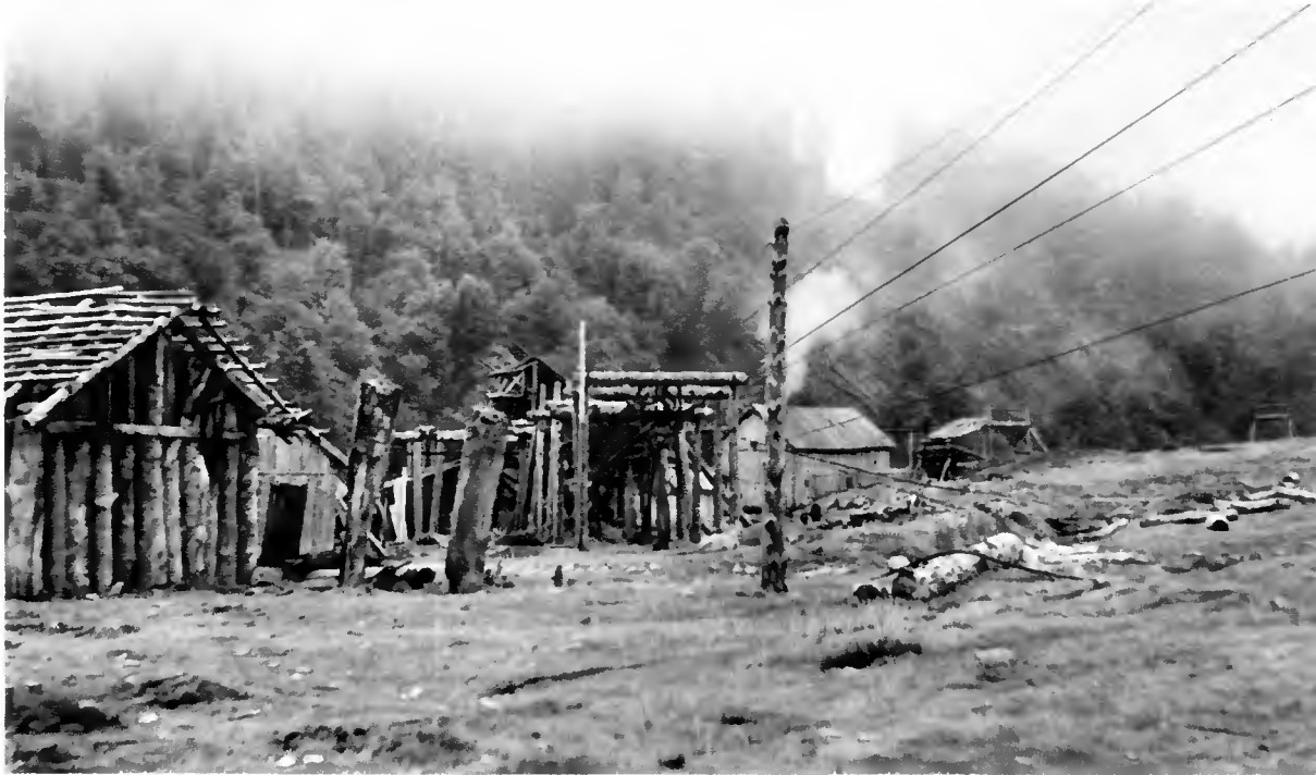
Les anciennes exploitations : départ du câble principal
